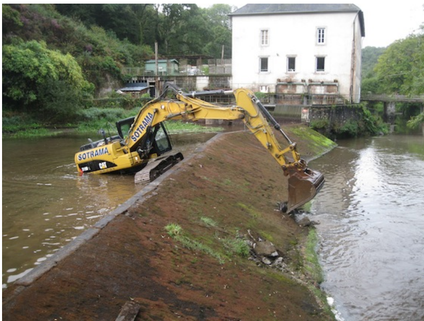
destruction d'un seuil
