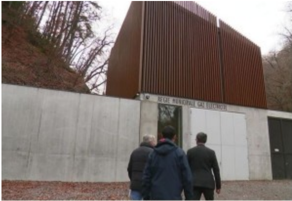
La centrale hydro-électrique de Sallanches - © France 3 Alpes
