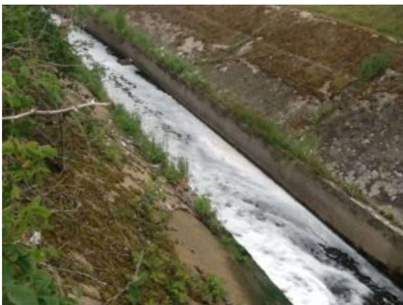
Une des sortie de la station d'épuration. Grand canal trapézoïdal bétonné.
