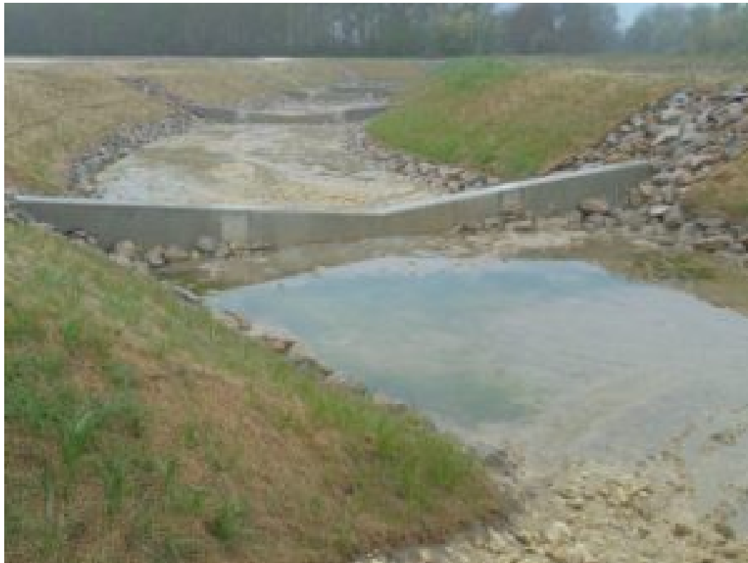
rivière de contournement vue de l'amont vers l'aval; un bel ouvrage inutile s'il n'est pas en eau.
