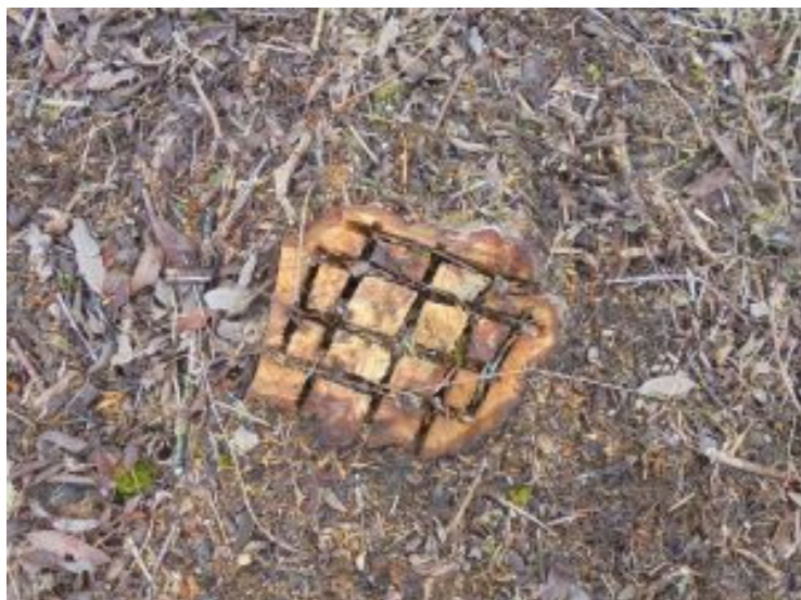
Un chantier très propre : saules coupés rez-terre, branchages brûlés, souches entaillées pour "empêcher les rejets". Tout cela dans quel dessein ?
