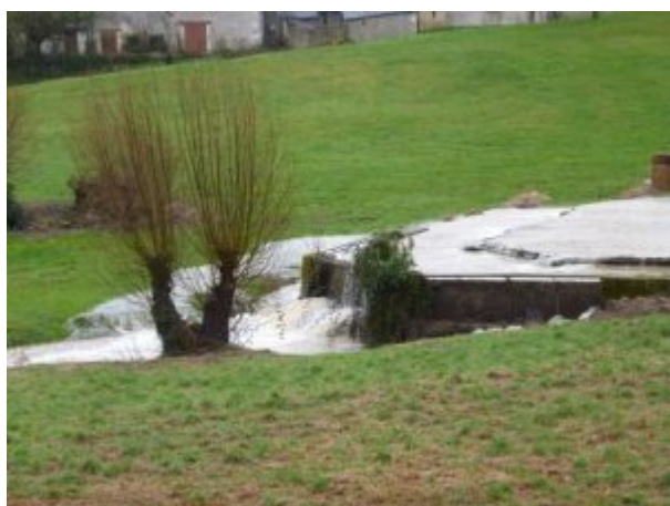
un système sous dimensionné, vite débordé...
