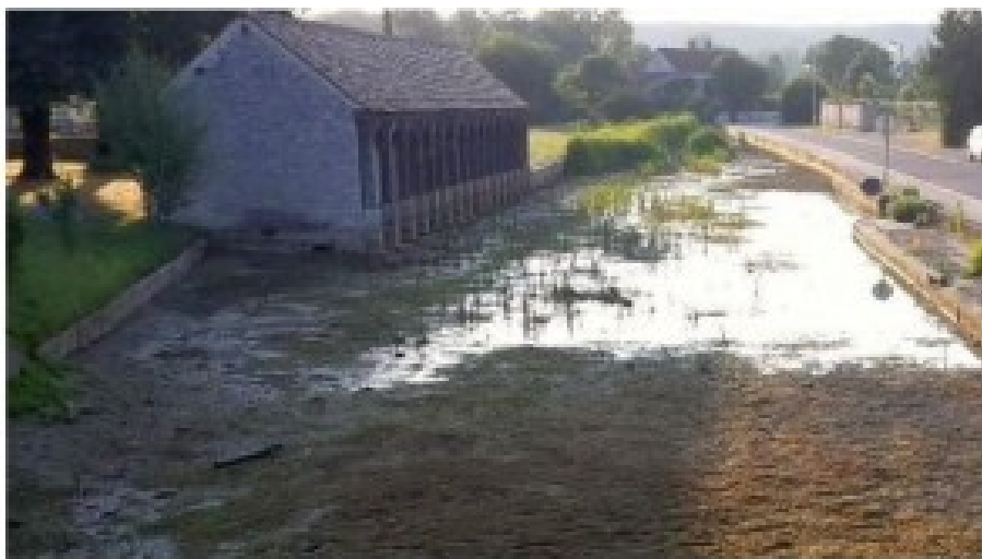
Le lavoir de Vanvey depuis l'entrée en vigueur de l'arrêté préfectoral du 8 juillet 2015
