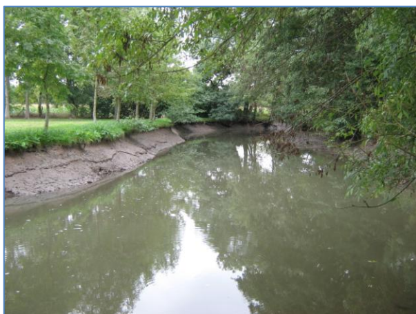
Vue des berges en amont de l'ouvrage, vannes ouvertes
