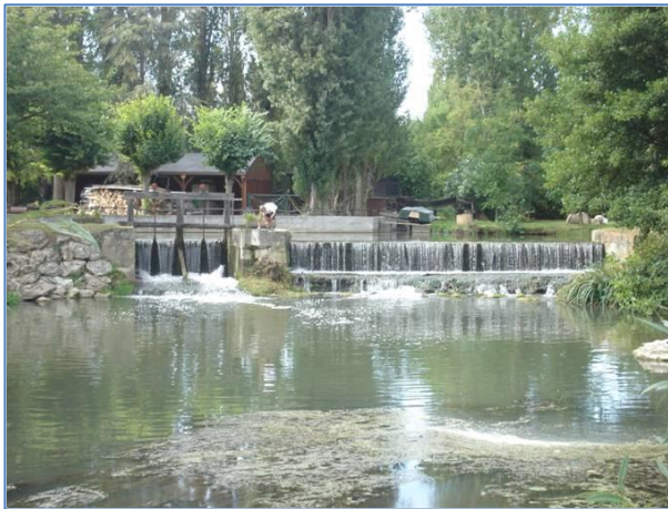
Vue aval de l'ouvrage, vannes fermées
