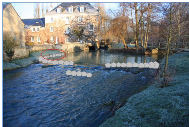
Vue aval du pré-barrage existant avec les nouvelles interventions
