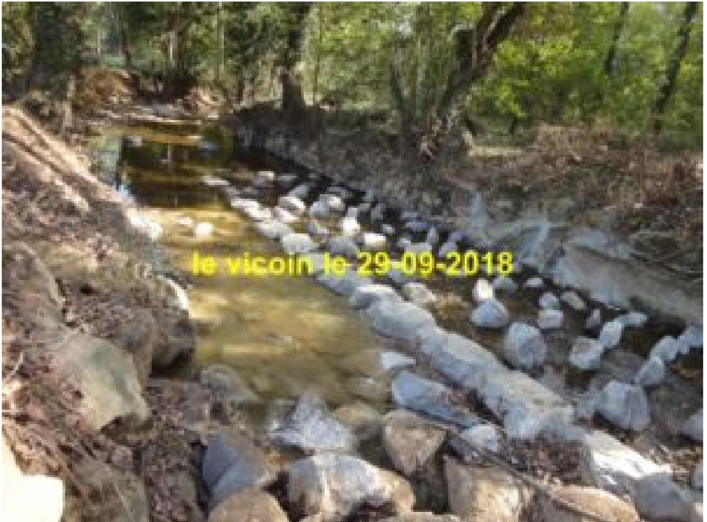
illustration: le site du barrage de Pontallain détruit en été 2018; des macro-rugosités rugueuses pour les nageoires (rochers permettant la circulation des espèces piscicoles) disposées au millimètre près selon les prescriptions de l'AFB (sinon le schéma n'est pas "conforme" à la croyance). Si en octobre 2018 les poissons sont tous plus ou moins morts, il faudra que l'AAPPMA locale empoissonne?
